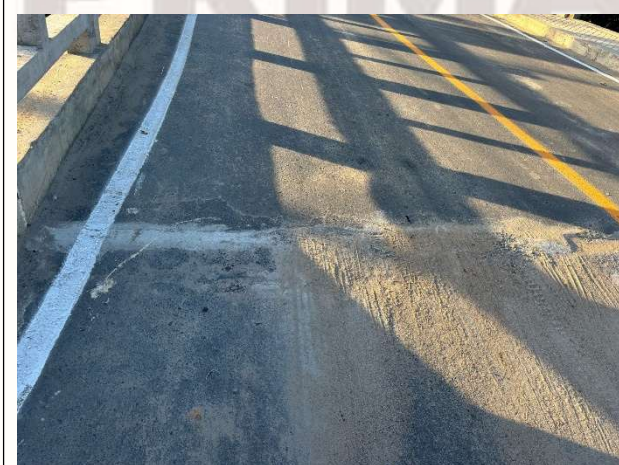
FOTO 5: SINALIZAÇÃO HORIZONTAL EXECUTADA;
