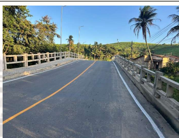
FOTO 2: SINALIZAÇÃO HORIZONTAL EXECUTADA;
