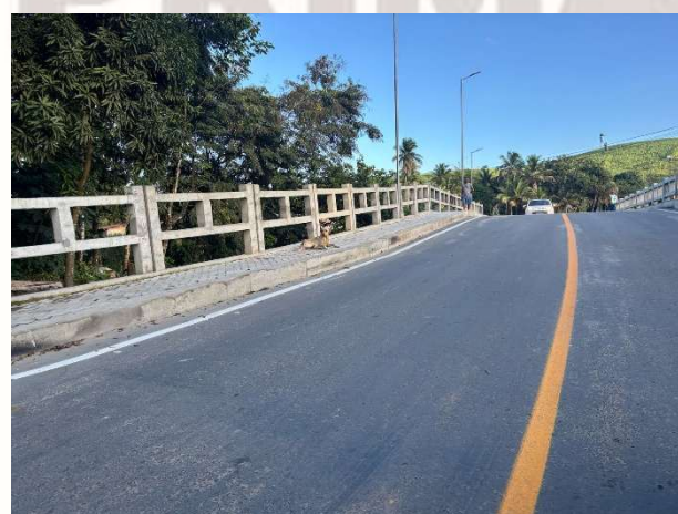
FOTO 11: SINALIZAÇÃO HORIZONTAL EXECUTADA;
