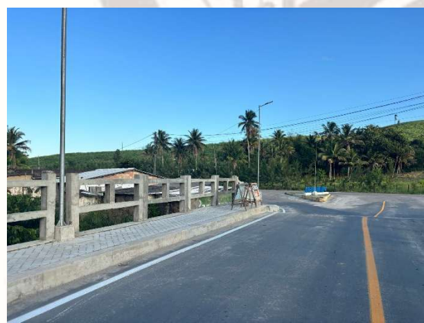
FOTO 09: SINALIZAÇÃO HORIZONTAL EXECUTADA;
