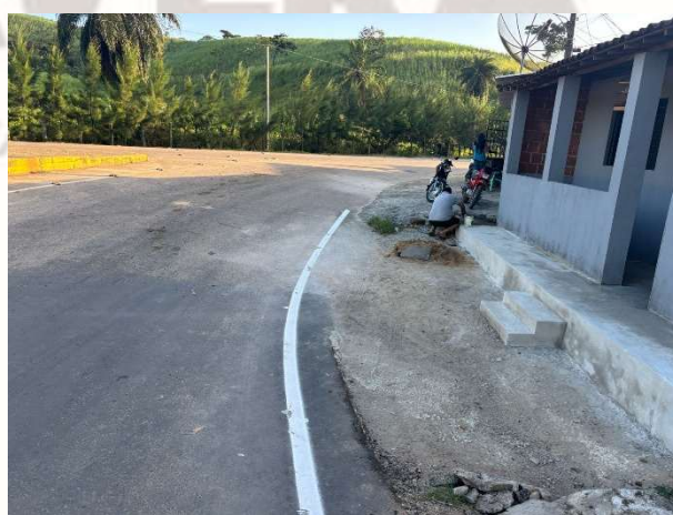
FOTO 12: SINALIZAÇÃO HORIZONTAL EXECUTADA;
