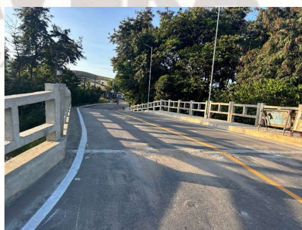
FOTO 6: SINALIZAÇÃO HORIZONTAL EXECUTADA;
