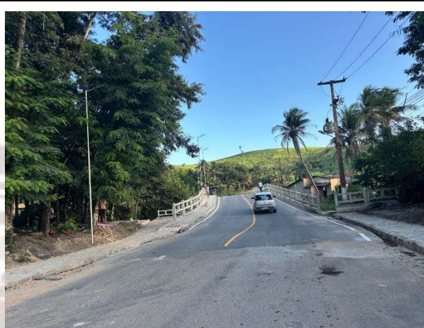
FOTO 8: SINALIZAÇÃO HORIZONTAL EXECUTADA;
