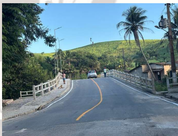
FOTO 10: SINALIZAÇÃO HORIZONTAL EXECUTADA;
